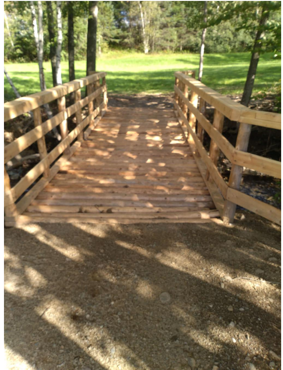
Photo 12 : Pont traversant le Venlo, le 4 septembre 2020.
