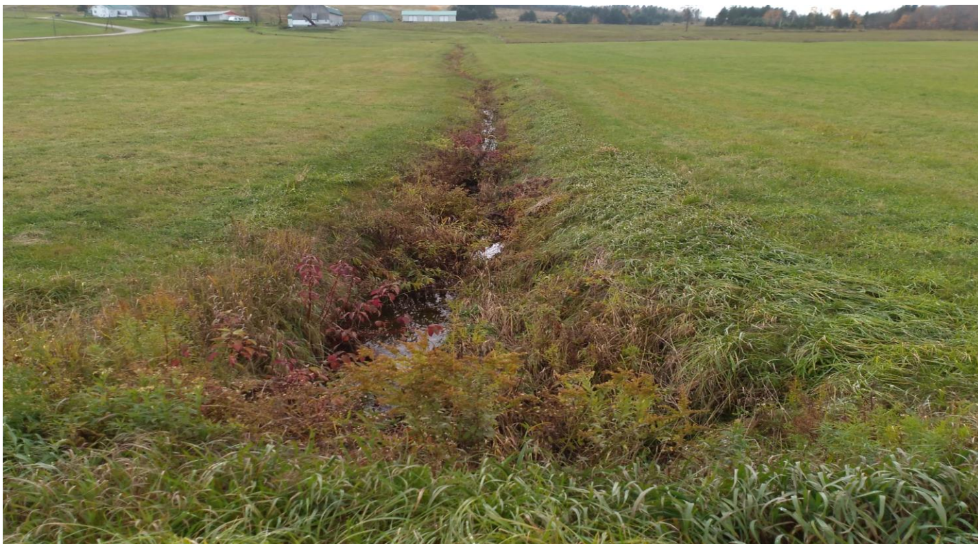
Photo 1 : Bande végétale riveraine non conforme en milieu agricole dans le sous-bassin versant du ruisseau Provencher, le 14 octobre 2020.
