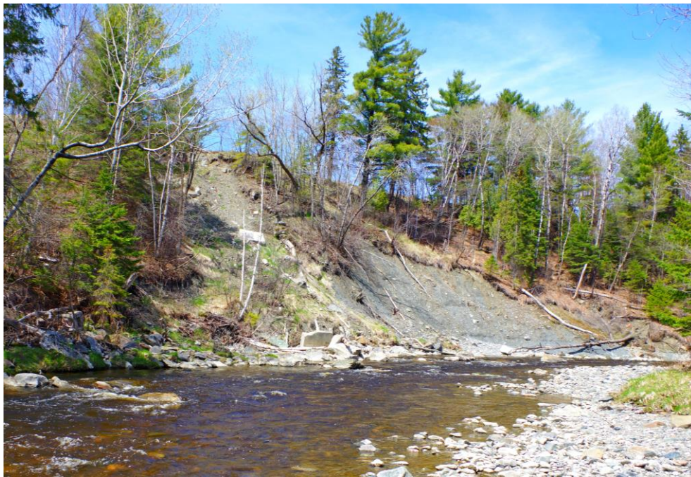
Photo 1 Vue générale sur la zone d'érosion.
