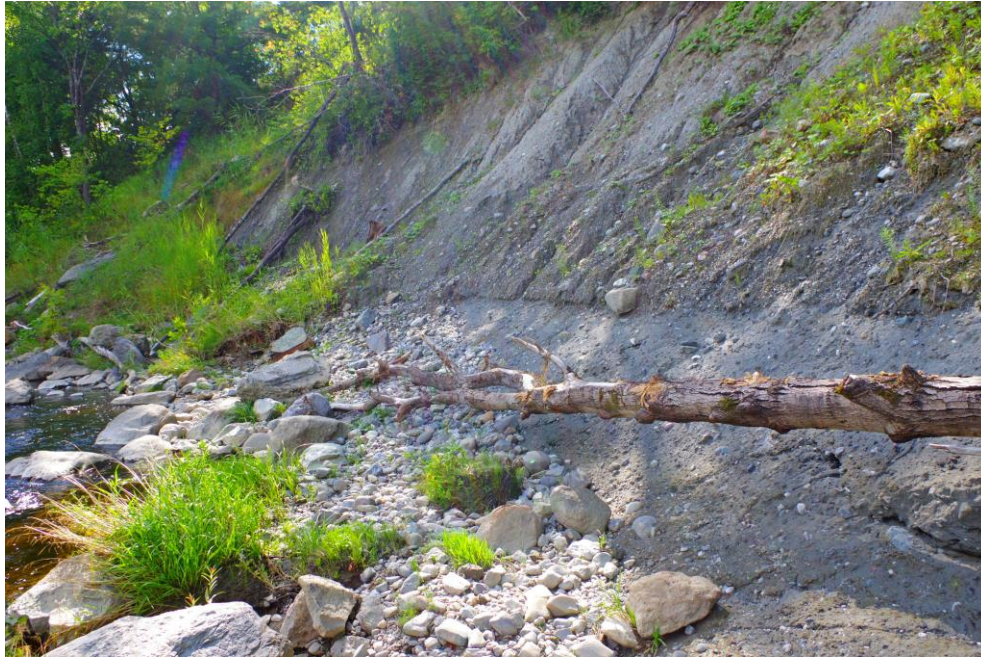
Photo 4 La partie inférieure du talus est recouverte d'alluvions d'une granulométrie étalée. La ligne des hautes eaux est clairement visible.
