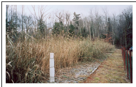
Figure 3. Système de roseaux épurateurs pour le traitement des eaux usées en bordure du lac Sunday.
