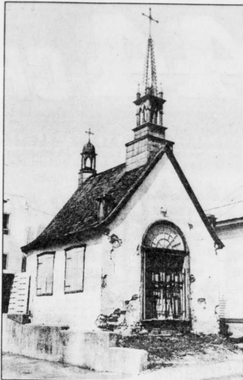
La chapelle Laberge, à l'Ange-Gardien, est dans un mauvais état. Heureusement, un groupe de citoyens projettent de la faire rénover et de l'ouvrir au public.
